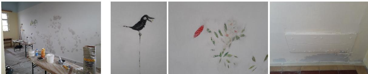
Fr., 20.01.2023 / 10-16h / Hauptwand reinigen / Flächenspachtel ausbessern / schleifen / reinigen / spachteln / farbige Elemente / Blätter / Vogel mit Pinsel reinzeichnen / Pöstlingbergwolke wird angedeutet zur späteren Ausführung / mit Wolken einen Übergang ins Blau der Decke bilden.
